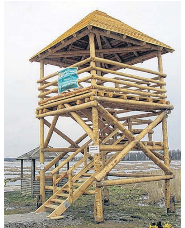
Der alte Aussichtsturm am Bugewitzer Deich wurde vor anderthalb Jahren abgerissen.
